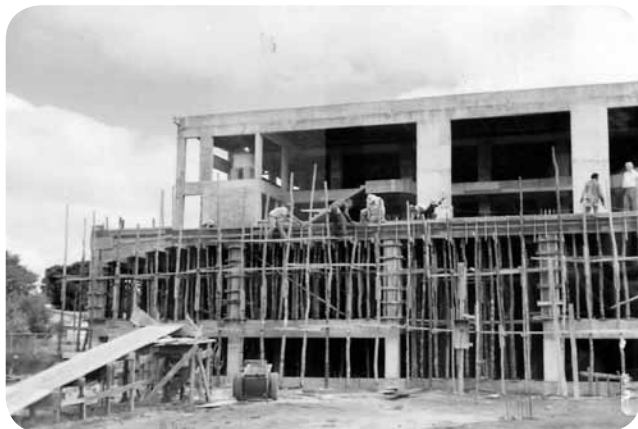
Construção do Templo
