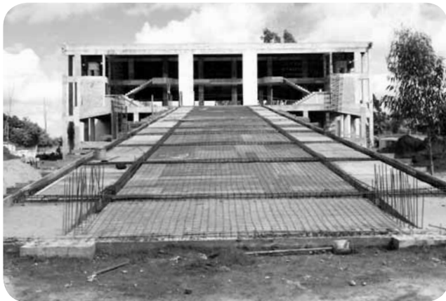
Construção do Templo - Rampa
